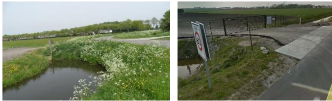
Vervangen van dammen door vaarduikers, soms met sluis / overtoom
