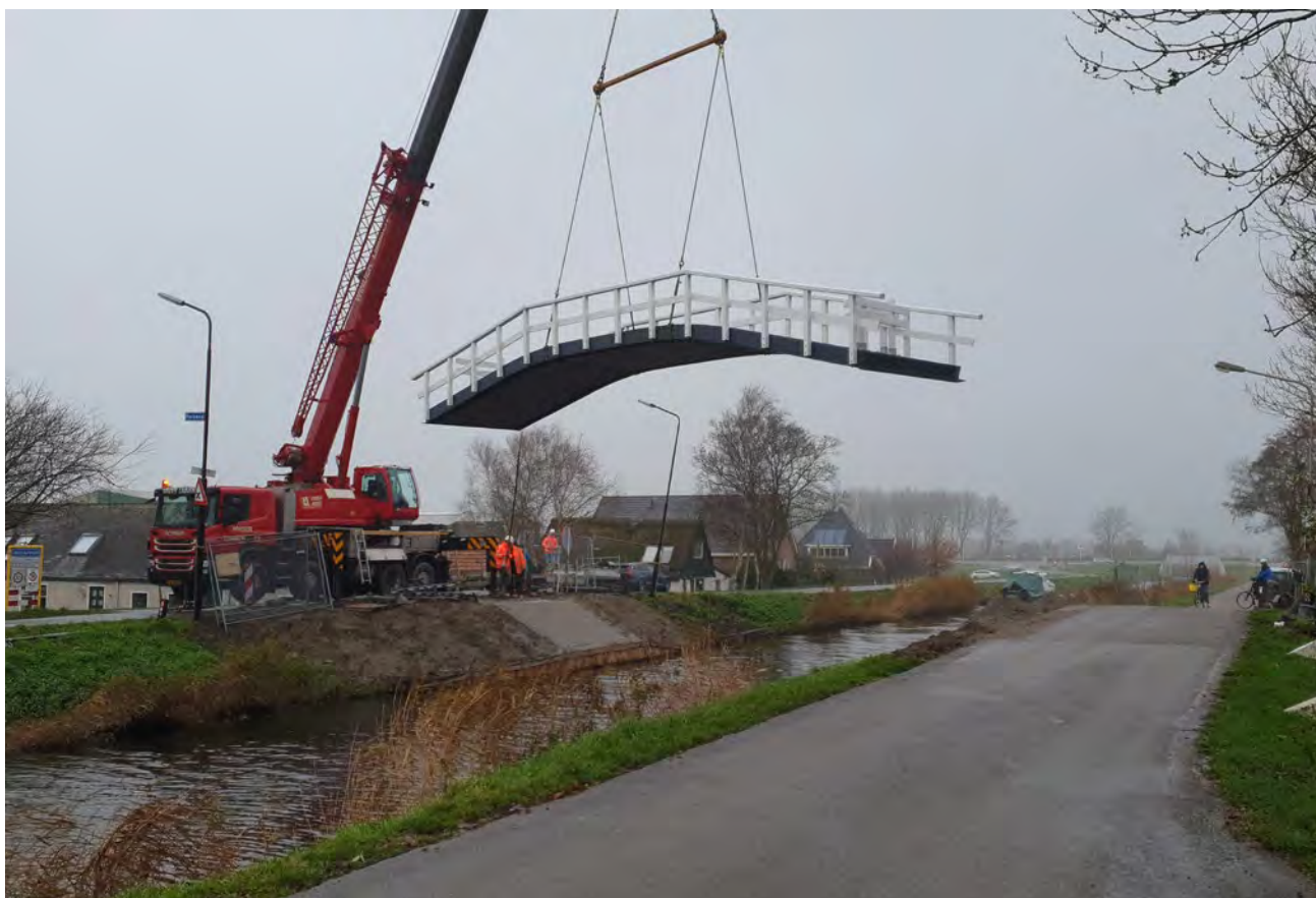
Met de plaatsing van de nieuwe brug in Veenhuizen is een knelpunt in het vaarrendje Rustenburg-Verlaat opgelost
