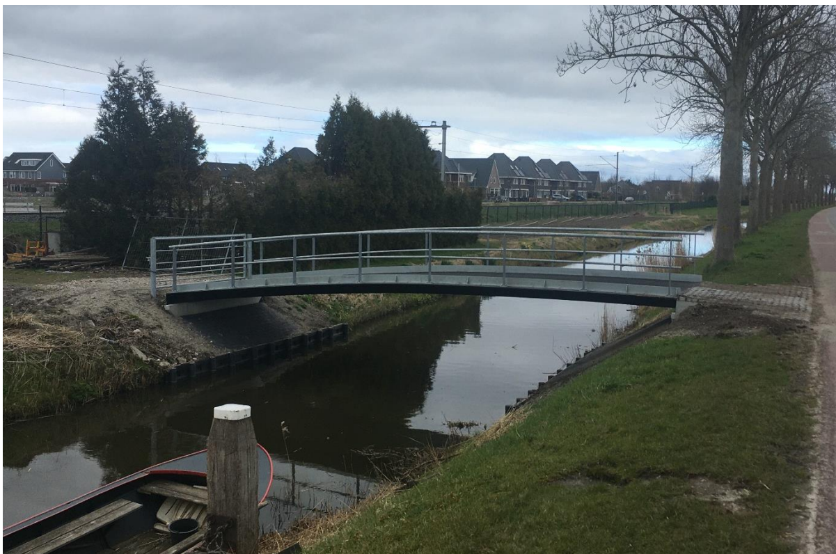
Gerealiseerde brug over de Wijzend in Drechterland
