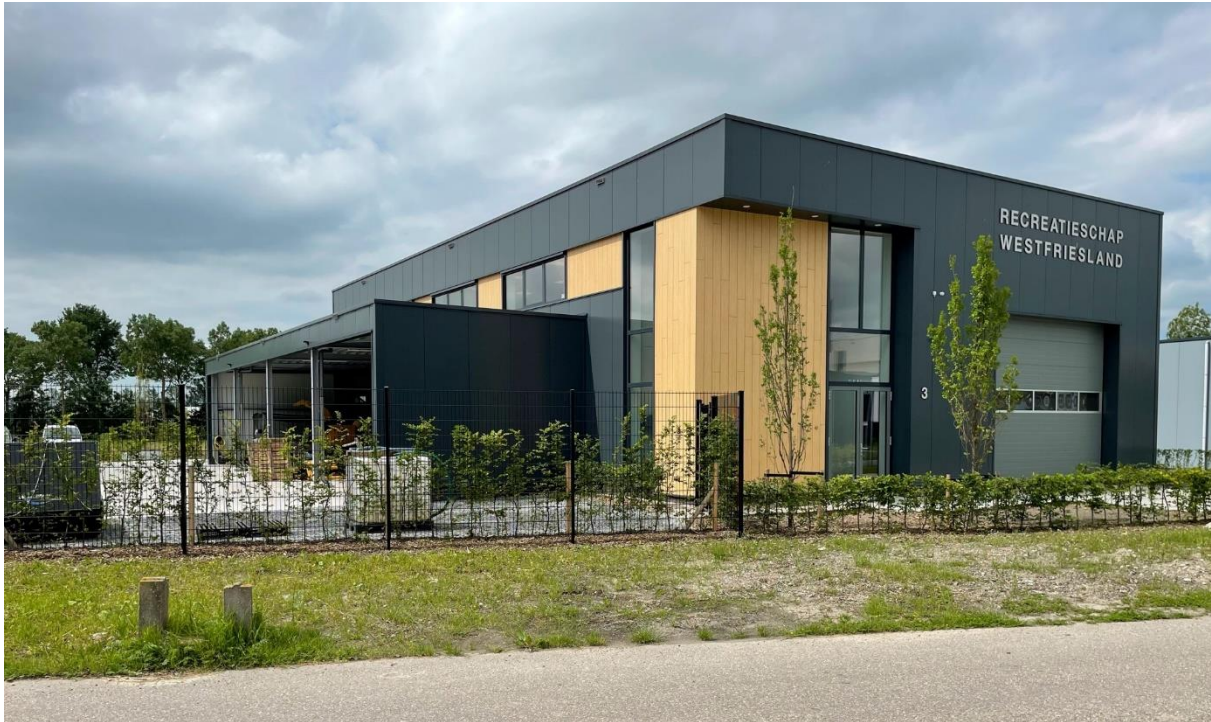
Het nieuwe bedrijfspand van de afdeling Groen- en Recreatiebeheer
