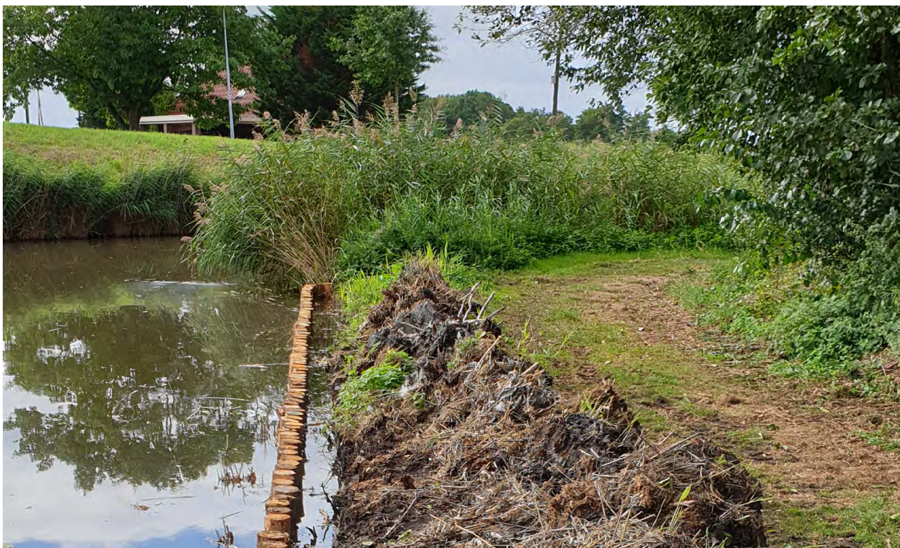
Zowel in De Hulk ( boven ) als in het Ecoproject in het Streekbos ( beneden ) gaat aannemer D. Koper aan de slag met de beschoeiing. De beschoeiing was na een flink aantal jaren toe aan vervanging.
