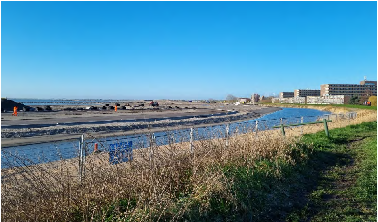
Stadsstrand Hoorn in aanleg
