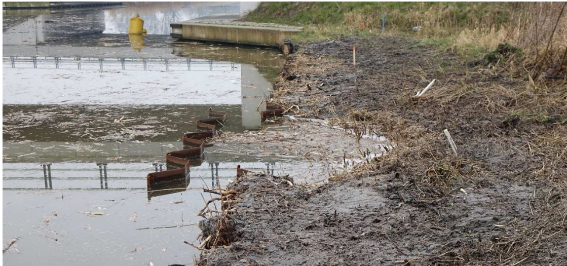
Figuur 4. Voorbeeld van een fauna uittreedplaats achter een harde oeverbeschoeiing
