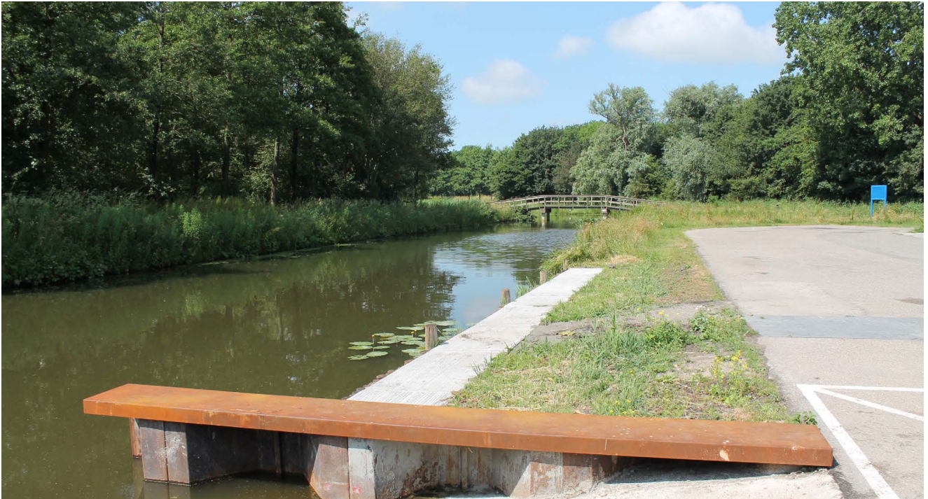
Nieuwe bootinlaat met aanlegplek
