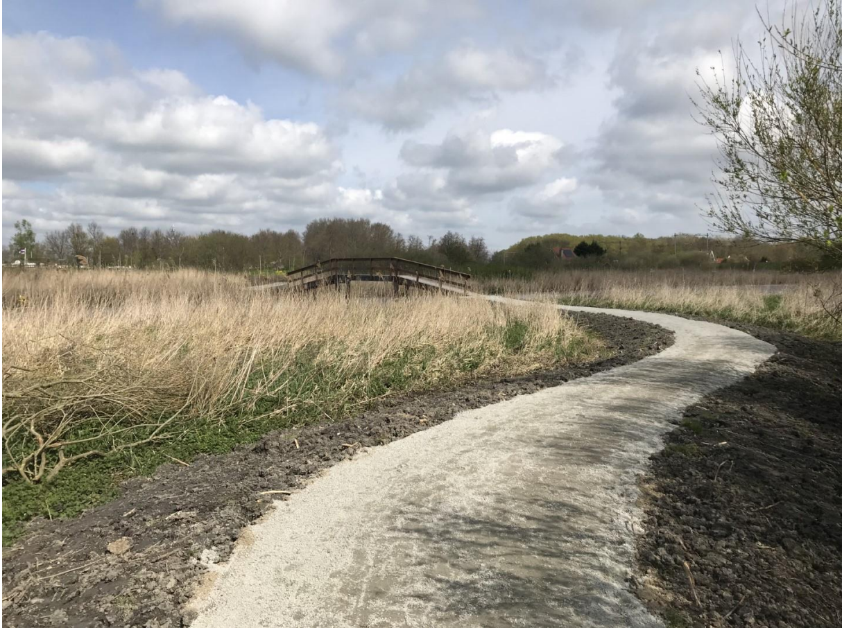
Een nieuw aangelegd wandelpad met brug in De Hulk
