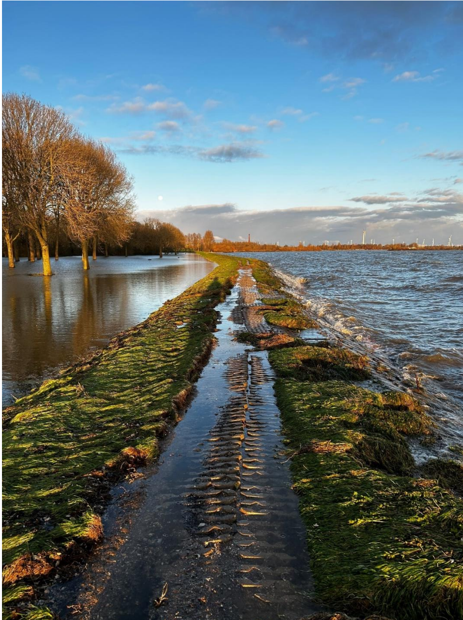
Storm Pia gecombineerd met een hoge waterstand zorgde er voor dat het Nesbos overstroomde
